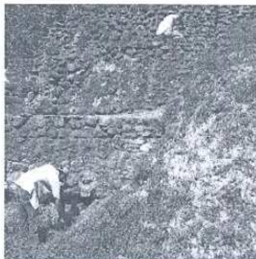
Foto 4. Trabajos de limpieza, Edificio 4, Grupo Maler
